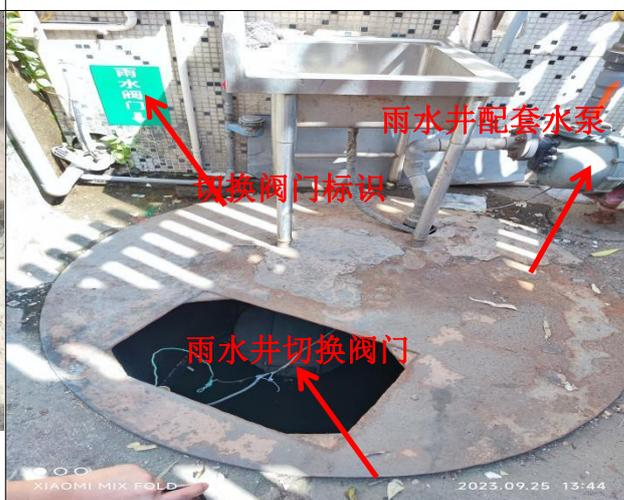
初期雨水收集池及应急切换阀门、水泵
