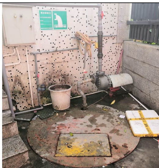
初期雨水收集池及应急切换阀门
